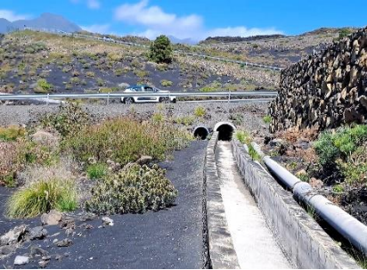
Neue Straße wegen Vulkanausbruch 2021.
