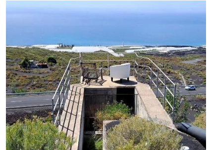
Exklusiver Sitz auf verlassenen Wasserbauwerk.
